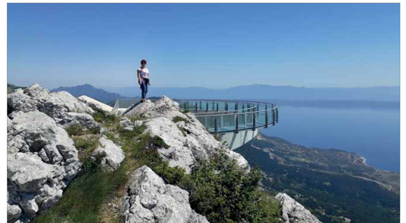
Nationalpark Biokovo: der noch abgesperrte Skywalk Biokovo. Die Stahlbetonkonstruktion mit einem Glassteg ist in einer Höhe von 1228 m angebracht und ragt 12 m aus der Klippe hervor. Er wurde erst 6 Tage später, am 2. Juli 2020, eröffnet.
