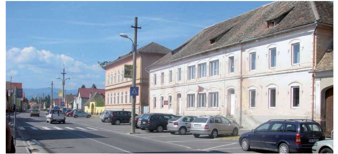
Die (ehemals) deutsche Schule in Neppendorf vor der Renovierung - Sommer 2011
