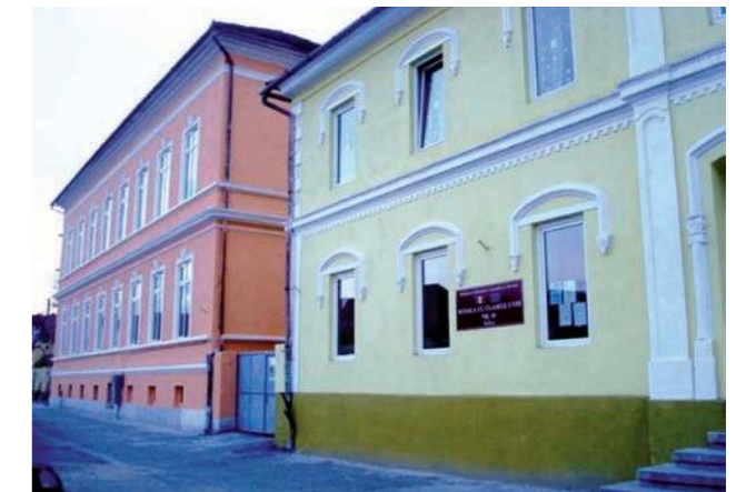
... nach der Renovierung - Sommer 2012
