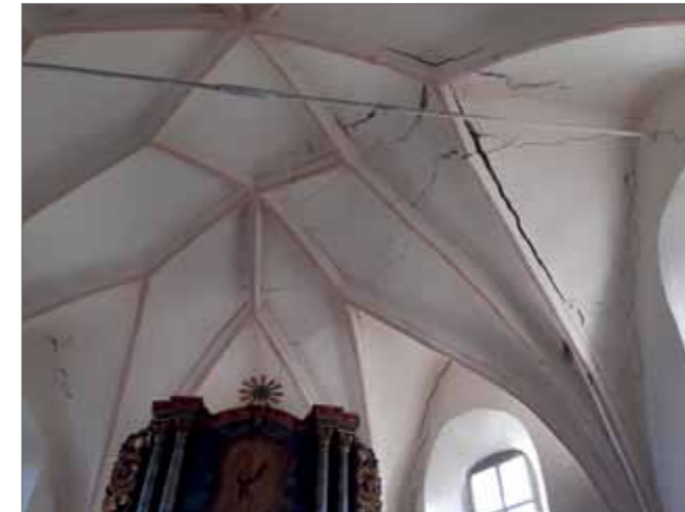
Die Risse im Mauerwerk der Kirche von Törnen waren so groß, dass seit Herbst 2019 aus Sicherheitsgründen keine Gottesdienste mehr in der Kirche gehalten werden konnten. Fotos: Angelika Beer
