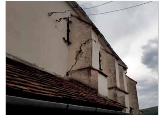
Die Risse im Mauerwerk der Kirche von Törnen waren so groß, dass seit Herbst 2019 aus Sicherheitsgründen keine Gottesdienste mehr in der Kirche gehalten werden konnten. Fotos: Angelika Beer
