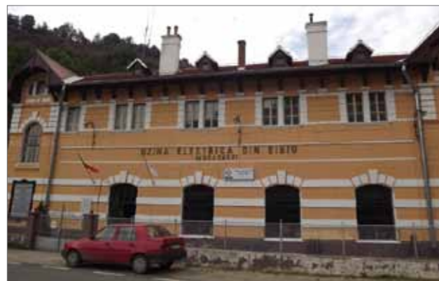
Wasserkraftwerk Zoodt ( Sadu)
