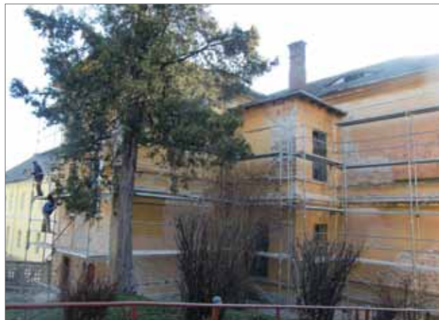
Allgemeinschule Nr. 10 Neppendorf: vor und nach den Renovierungsarbeiten
