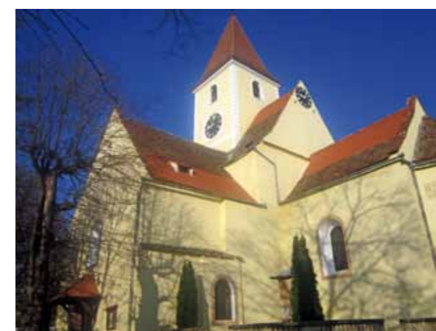
oben: Die Heimatkirche nach der Dachsanierung links: Die 10er-Schule in neuem Glanz
